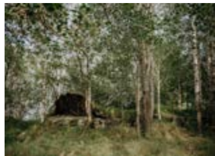
Kanonstilling for 2 cm Flak, skyts nr 5, nedgravd i bakken. Veggav opplødd stein, kraftig attgrodd. Lokalisert ved sjøen på Espeneset.
