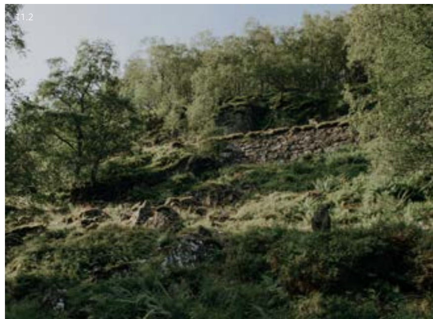
Øvst i bildet ser ein støttemur til vegen opp Brattekakken, bygd på slutten av 1930- talet.
