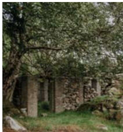
Mur etter mannskapsbrakke
